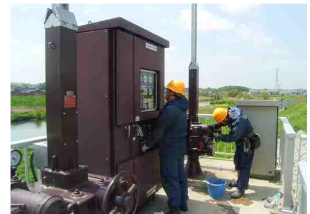
河川管理施設の点検状況
