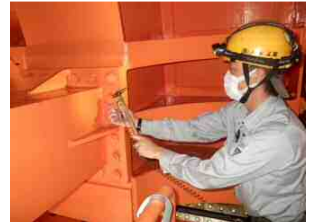
放流設備の点検
