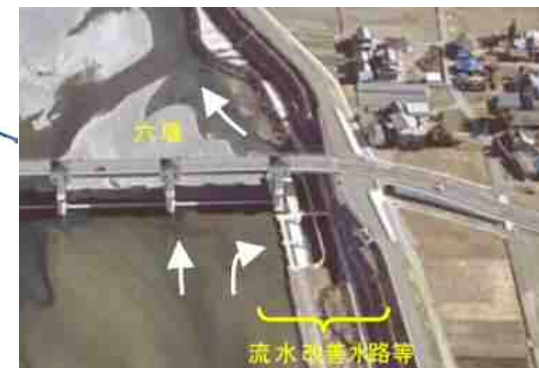
流水改善水路(六堰)
