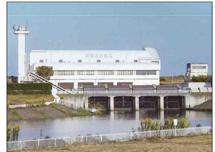
綾瀬排水機場
