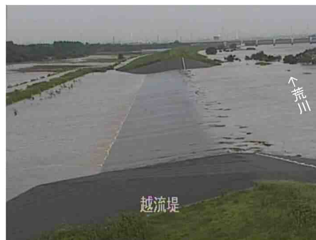
平成19年9月洪水 越流堤からの流入状況
