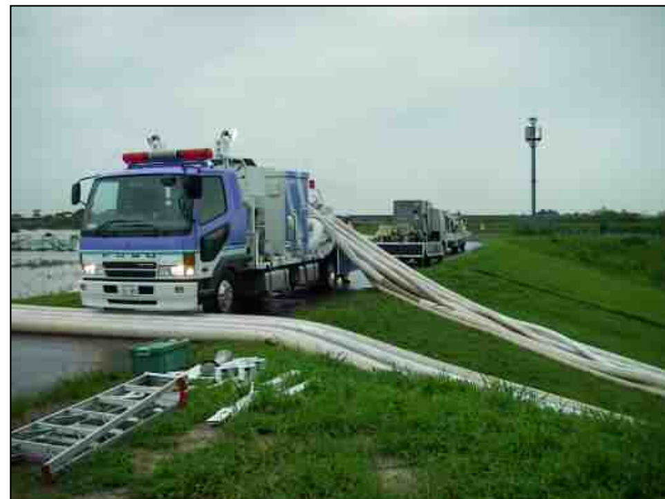
災害時の排水ポンプ車出動状況
