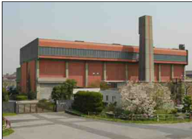
新芝川排水機場
