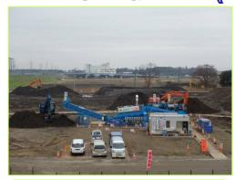
三郷市高水敷より掘削した土砂を 万能土質改良機で混合しています。
