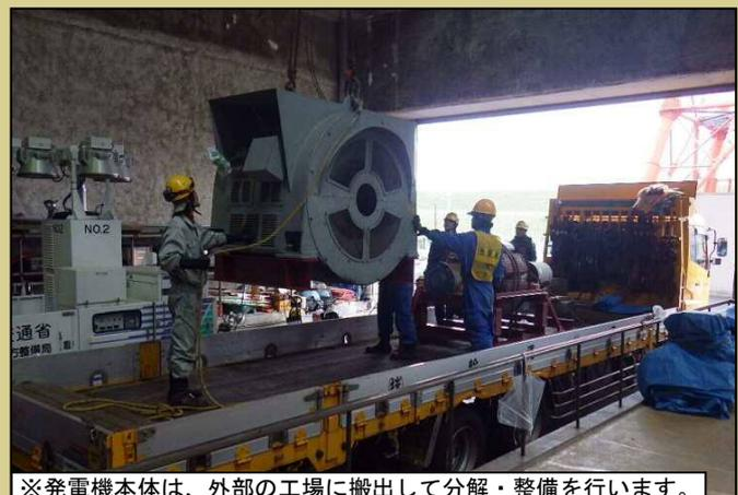
※発電機本体は、外部の工場に搬出して分解・整備を行います。
