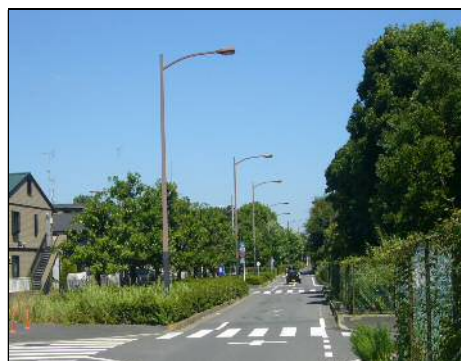
〈国道298号 上矢切付近〉
