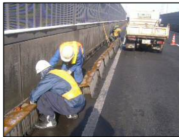
〈側溝清掃（機械）〉
