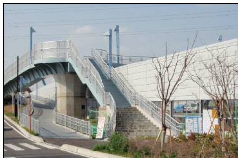
〈国道298号 矢切南台歩道橋 (横断歩道橋)〉
