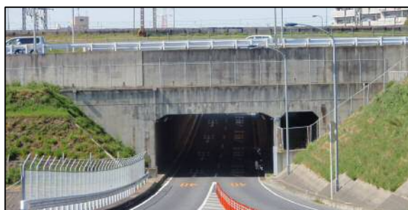
〈国道298号 上矢切隧道 (国道6号交差部)〉
