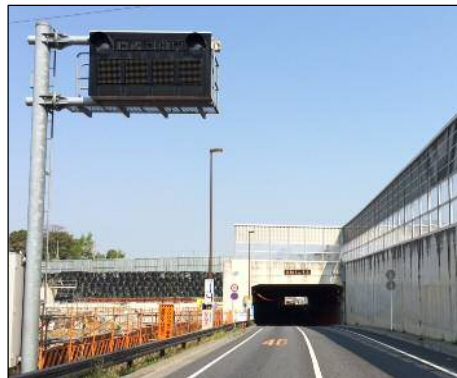
〈国道298号 上矢切付近〉
