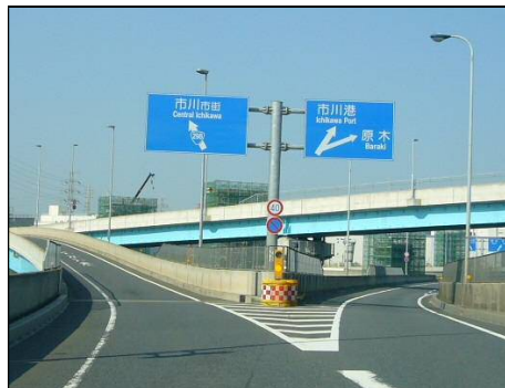
〈国道298号 高谷ランプ付近〉
