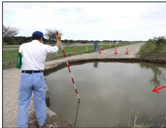
○道路の侵食状況 (9. 14)
