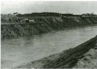
荒川改修工事（埼玉県さいたま市馬宮付近） 初期工事と併せて築造が行われ、工事には蒸気機関車や馬車・トロリーを使用している様子が見える。 写真は正統10年頃。
