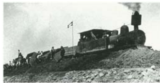
荒川改修工事（埼玉県さいたま市馬宮付近） 蒸気機関車による土運搬の様子。 土の運搬には3m3土運車がいられ20〜23台編成で運行された。
