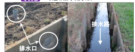
写真③ 排水路と排水口状況 撮影：平成27年11月
