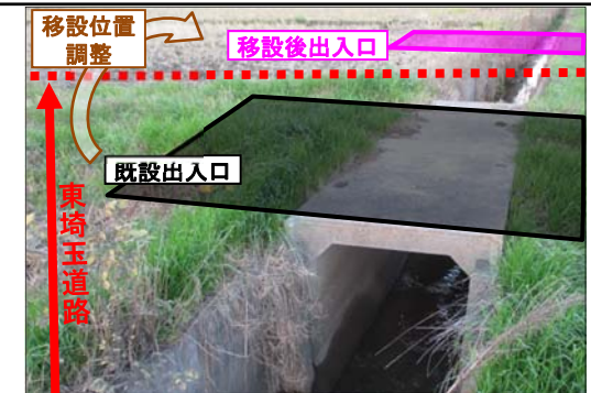
写真① 水田への出入口状況 撮影：平成27年11月
