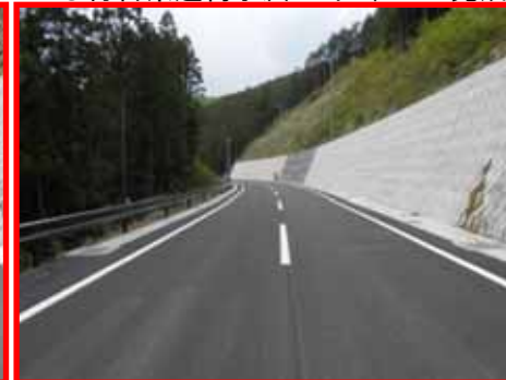
●付替県道杓子沢5工区(H26. 5完成)
