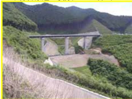
●付替県道6号橋(H23.10竣工)
