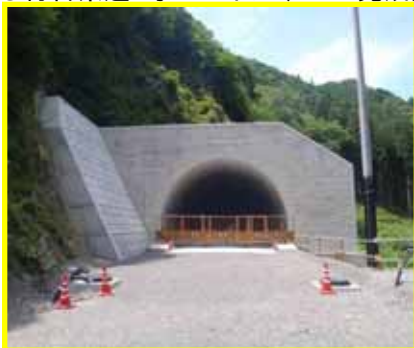
●付替県道1号トンネル(H24. 8完成)
