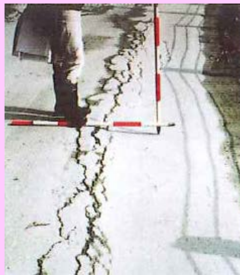
国道462号等の道路に発生した亀裂(平成3年)
