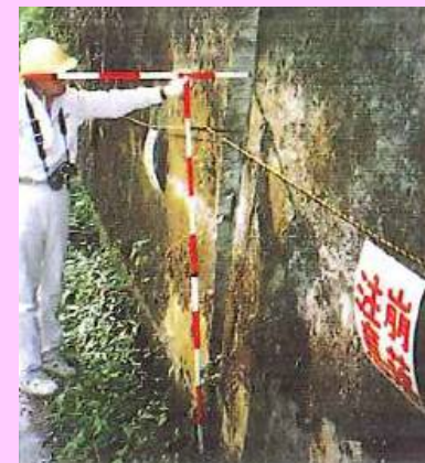
ようへき 擁壁に発生した亀裂や傾き(平成3年)
