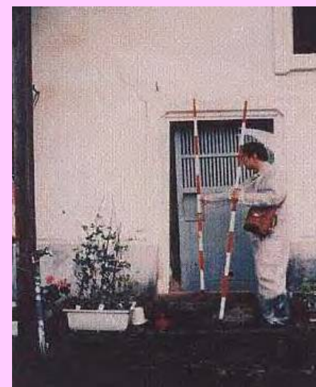
家屋の傾倒(平成3年)
