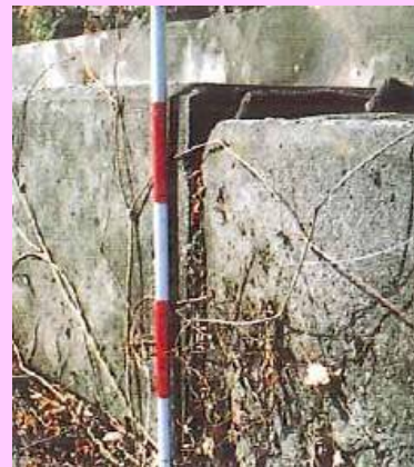
ようへき 擁壁に発生した亀裂や傾き(平成3年)
