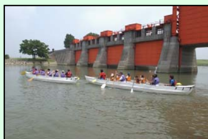
▲歴史的な施設(旧岩淵水門)
