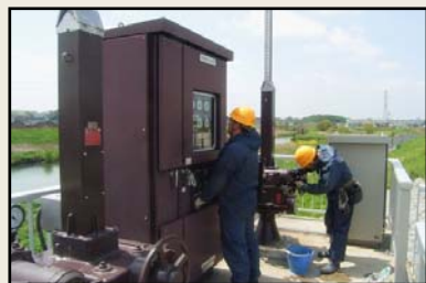
▲河川管理施設の点検状況
