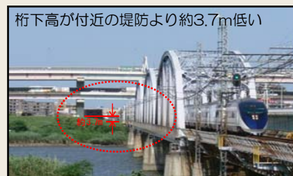
▲京成本線荒川橋梁
