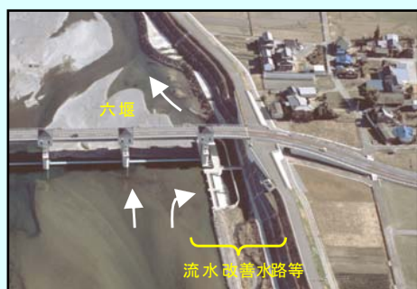
▲流水改善水路
