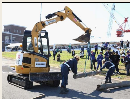
▲緊急用河川敷道路の活用
