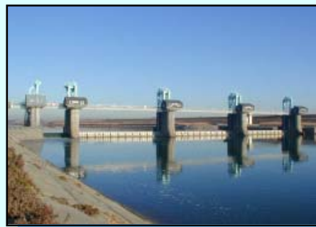
▲秋ヶ瀬取水堰(昭和40年完成)
