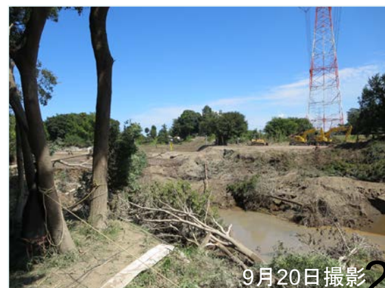
⑤溢水箇所(24.75k付近)排水後
