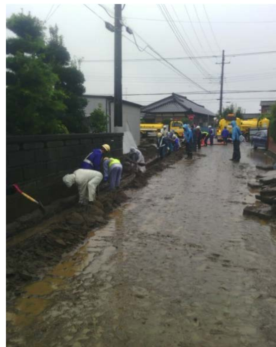
人力による堆積土の撤去
