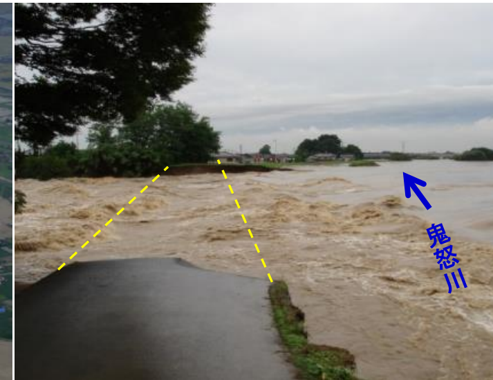
被災状況(拡大写真)
