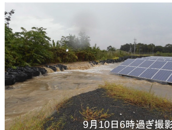
①溢水箇所(25.35k付近)溢水状況
