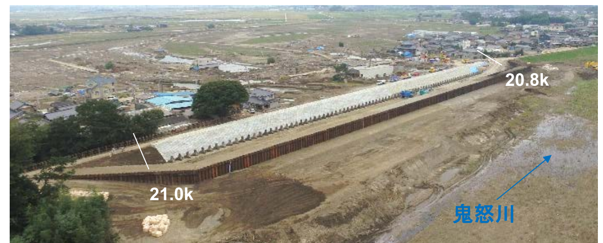
応急復旧状況(9/24)
