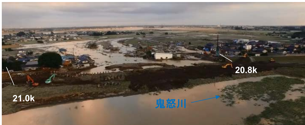
応急復旧状況(9/12)
