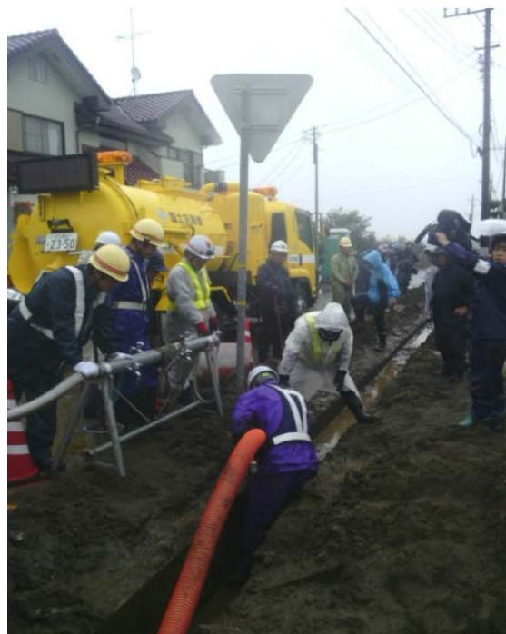
側溝清掃車による堆積土の撤去
