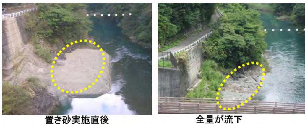
※宮ヶ瀬ダムのフラッシュ放流の際に、付着藻類の剥離効果を向上させる目的でダム下流にクレンジング材として置き砂を実施。
