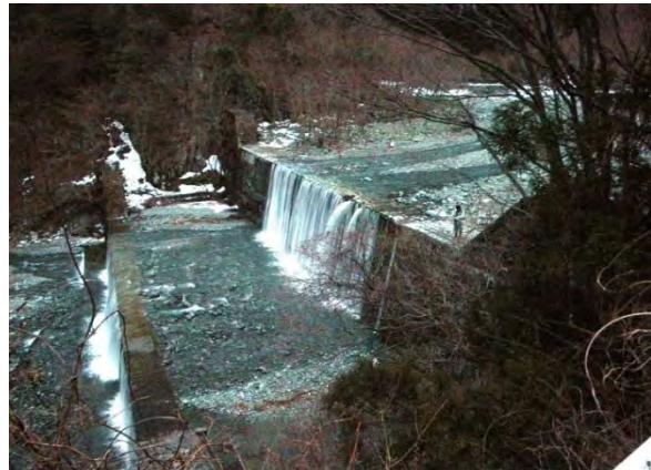
写真 1.4.2 相模川水系 神ノ川長者舎堰堤（相模原市）（不透過型砂防堰堤、S34 完成）
