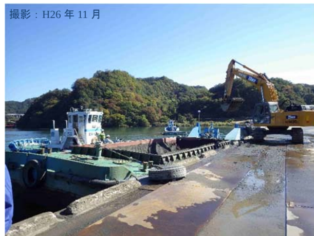
写真 2.2.2 相模ダム浚渫の実施状況
