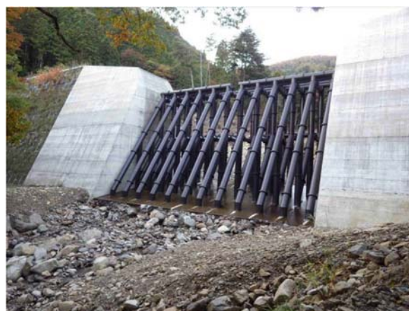
写真 1.4.3 相模川水系 笹子川・滝子川砂防堰堤（透過型砂防堰堤、H26.3 完成）
