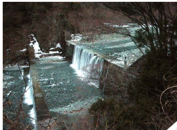
写真 1.4.2 相模川水系 神ノ川長者舎堰堤（相模原市）（不透過型砂防堰堤、S34 完成）
