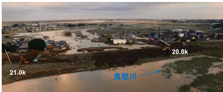
応急復旧状況(9/12)
