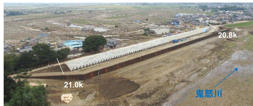
応急復旧状況(9/24)
