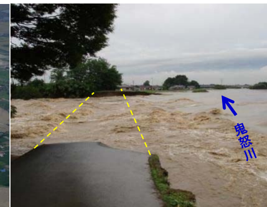
被災状況(拡大写真)
