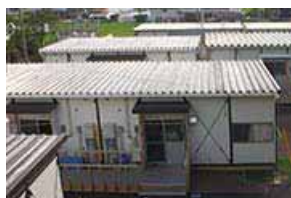
応急仮設住宅の建設
