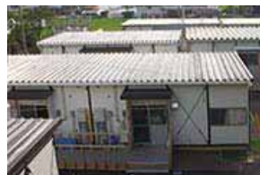
応急仮設住宅の建設 (出典)一般社団法人プレハブ建築協会HP
