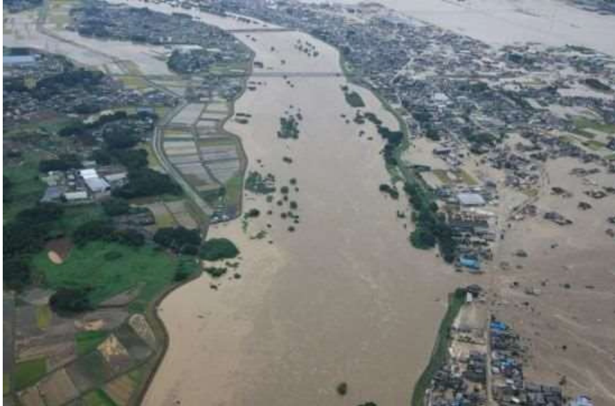
茨城県常総市における鬼怒川堤防決壊の様子(国土交通省資料より)
