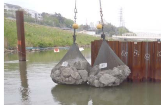
撤去ガラを袋詰め根固めとして再利用 <参考>平成24年度事業評価資料
