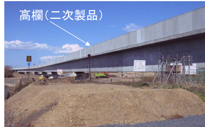
JR水郡線橋梁(新橋)
