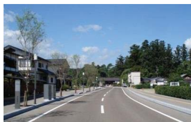
【電線共同溝方式による無電柱化】
