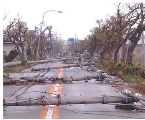
台風で倒壊した電柱が完全に道路を塞いでいる
