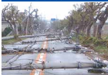
電柱の倒壊による道路閉塞
