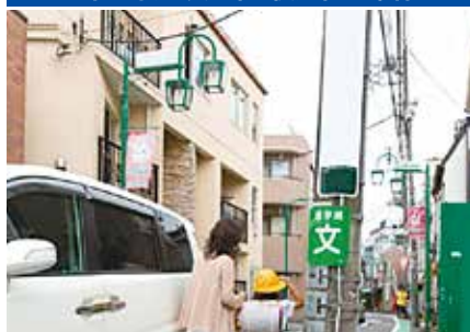
歩行の支障となる電柱
