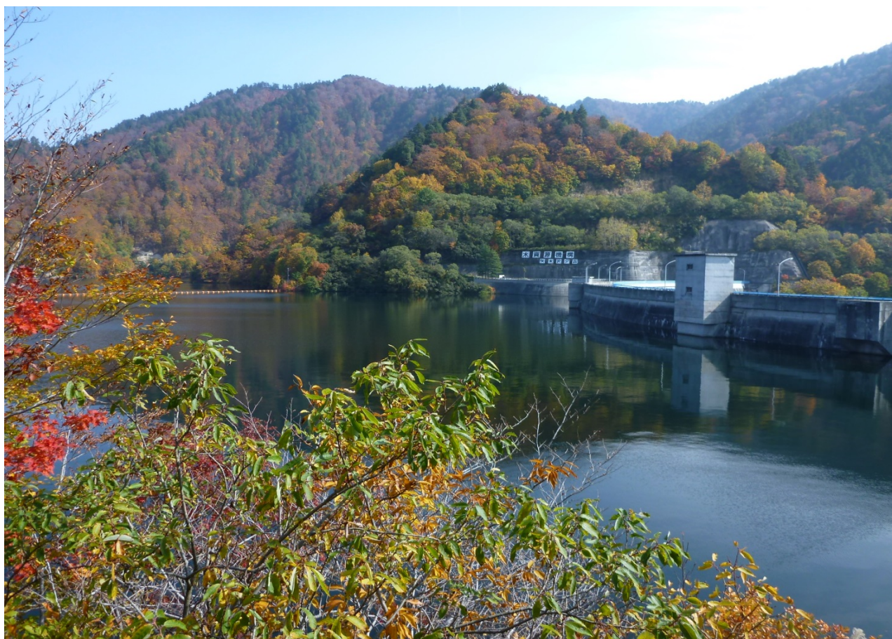
矢木沢ダム（平成27年10月20日撮影）
