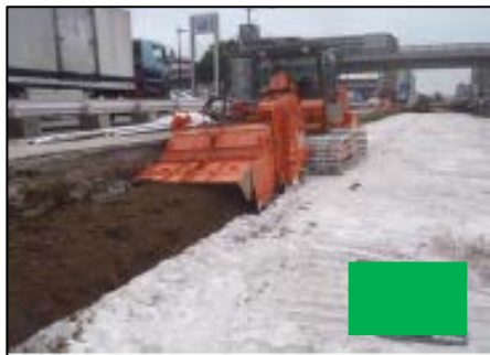
混合攪拌状況
