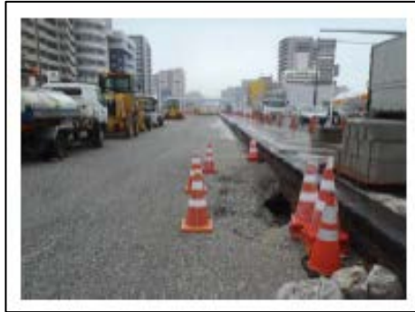
路面陥没状況
