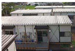
応急仮設住宅の建設
