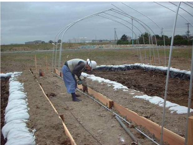
ビニールハウスの骨組みを差し込むための穴の作製（礫が多く、ドリルで削孔後に、スコップにより掘削した）
