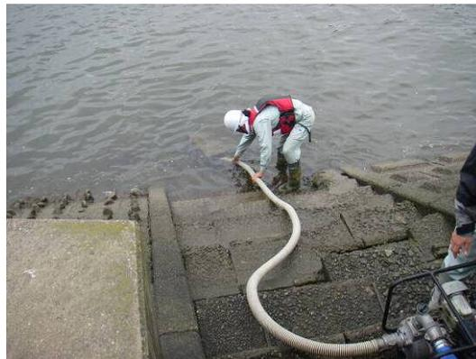
写真 5. 10 エンジンポンプによる吸水
