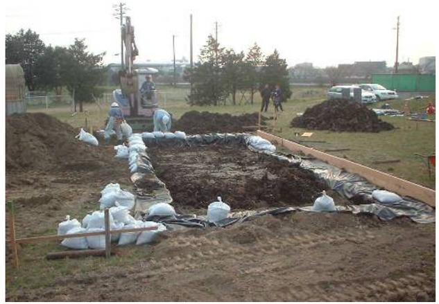
土嚢により遮水シートの周囲を固定
