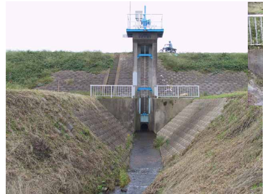
野爪排水樋管 昭和 29 年設置
