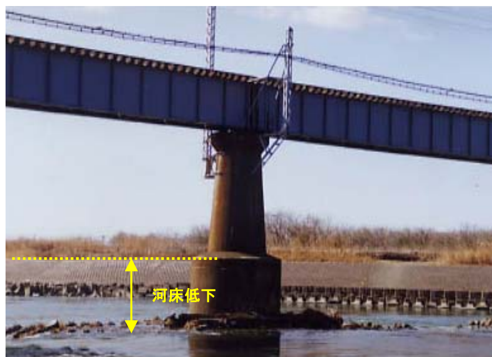
J R 水戸線鬼怒川橋梁
