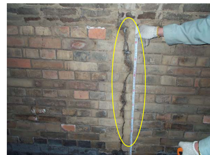
江口排水樋管
