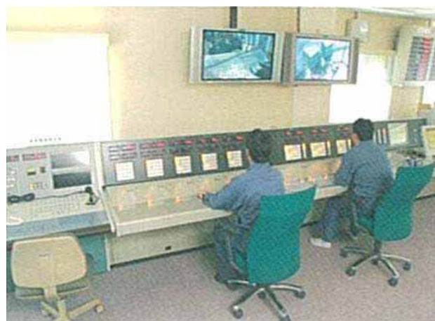
ダム操作（流量管理）状況
