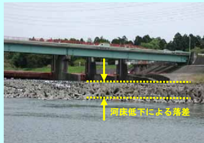
勝瓜頭首工下流
