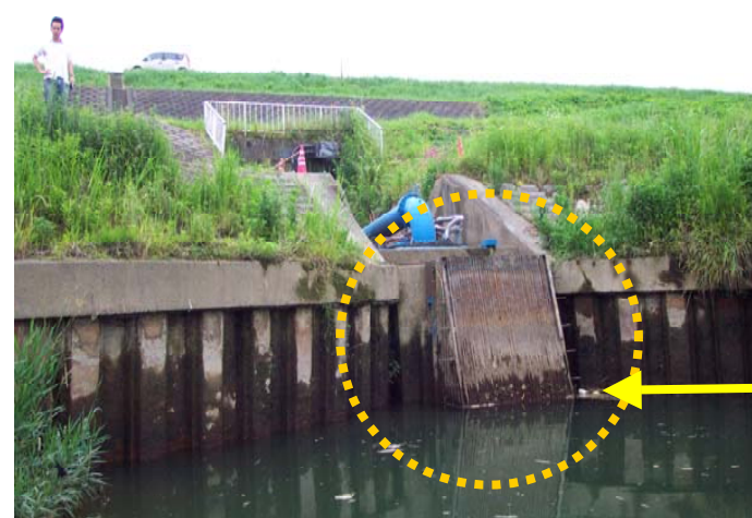
高崎揚水樋管
