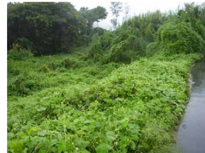
河川敷の植生の繁茂状況
