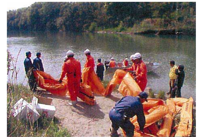
水質事故の状況 （オイルフェンスの設置状況）
