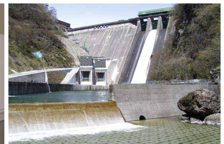
ダムの確実な操作
