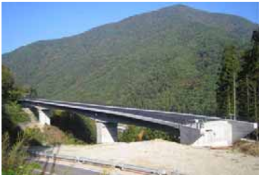
付替県道 橋梁工事
