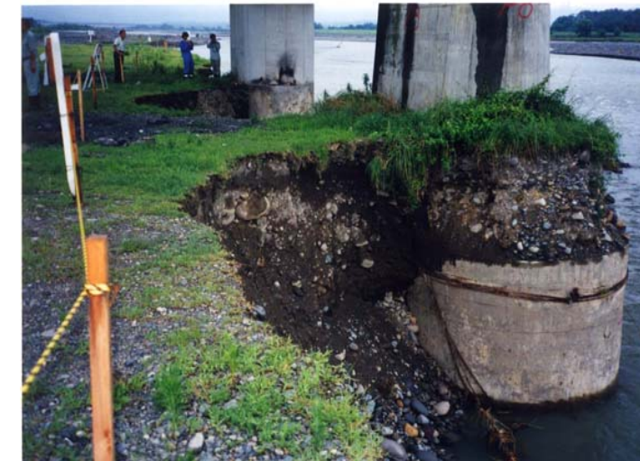
平成13年9月洪水 橋脚基礎の深掘れ状況 東北新幹線橋梁
