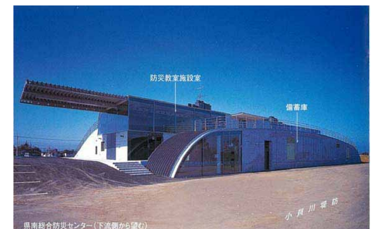
藤代地区河川防災ステーション
