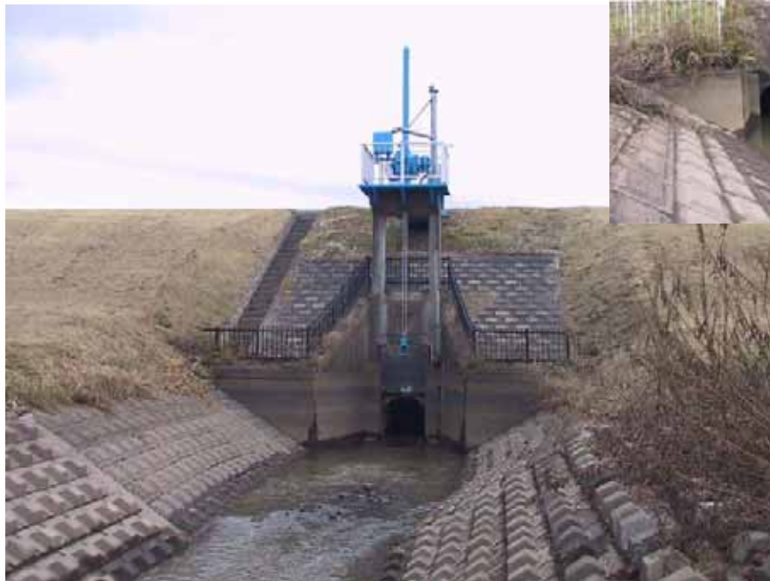
豊里排水樋管 昭和 39 年設置
