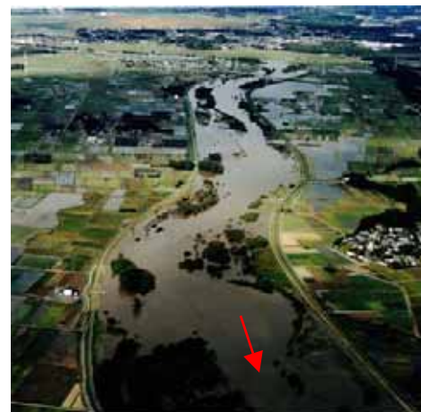
平成16年10月洪水41km付近 （愛国橋上流）
