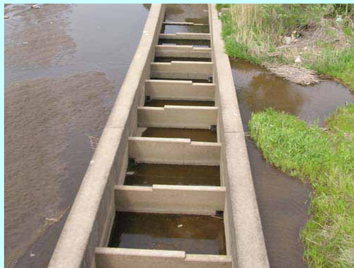
洪水時の魚道の状況
