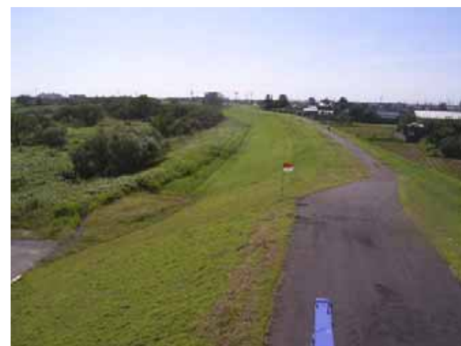
堤防の高さ及び断面が不足 取手市中内地先
