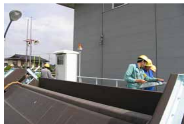
機場点検状況（伊丹排水機場）
