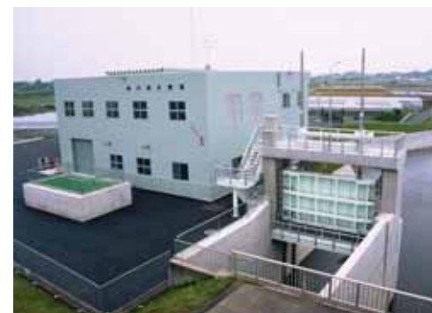
姥川排水機場 (H18.5完成)
