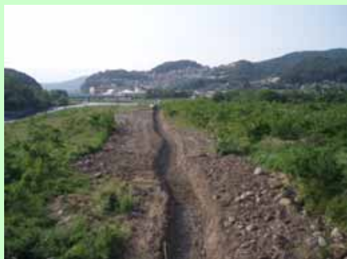
水路掘削直後
