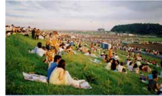
利便性向上、利用の推進を図るため、特に市街地においては緩傾斜堤防を整備
