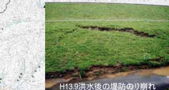
計画高水位までの洪水流量による浸透に対して、堤防の安全性を確保し、堤防の決壊による壊滅的な被害発生のリスクを軽減する必要があります。
