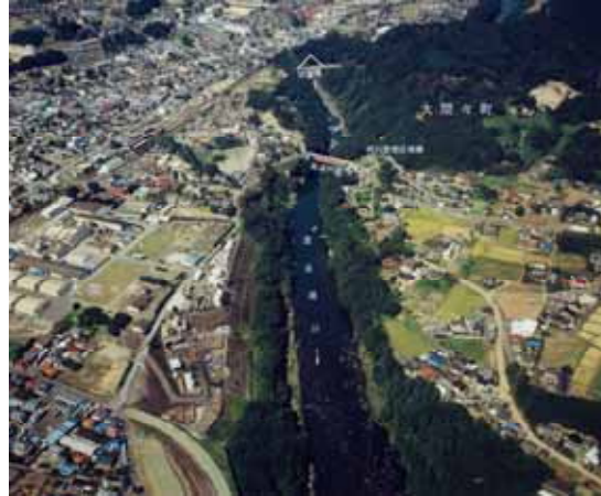
上流端(みどり市大間々町高津戸)
