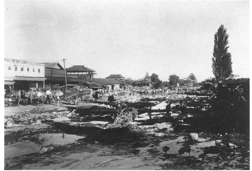
氾濫流が流下した桐生市昭和通り
