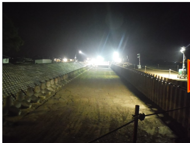
締切工完了（9月24日20:45頃撮影）
