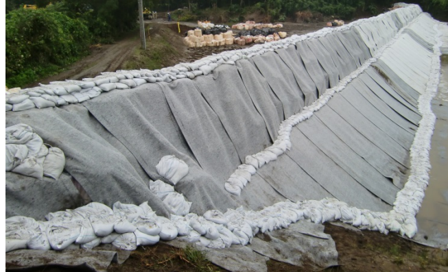
9月25日 大型土のう設置終了 (L=209m)
