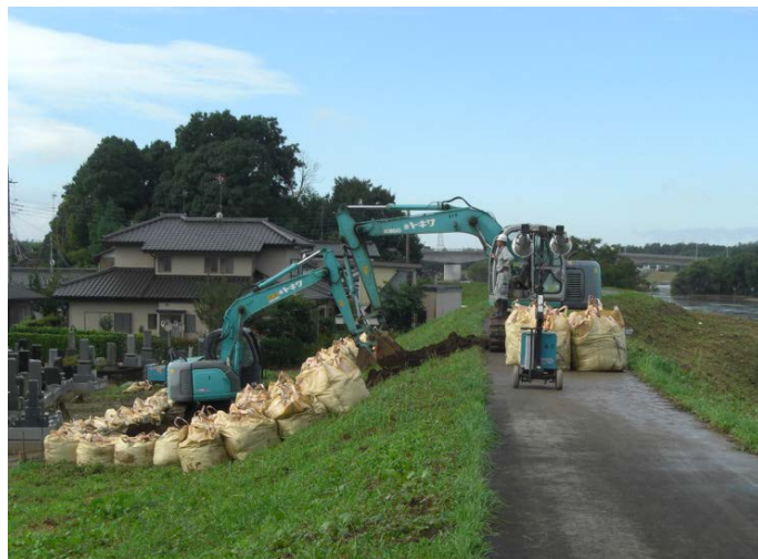
下流作業ヤード（9月11日8:00頃撮影）
