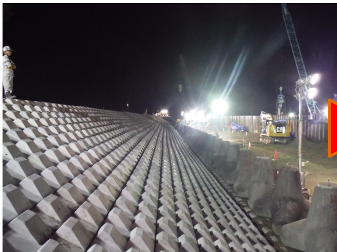
荒締切工完了 (9月20日3:00頃撮影)
