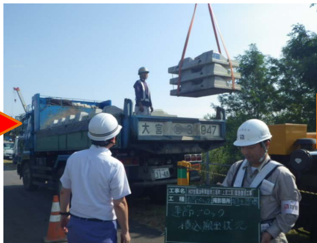
(備蓄)連節ブロック積み込み・搬出(桐生川)
