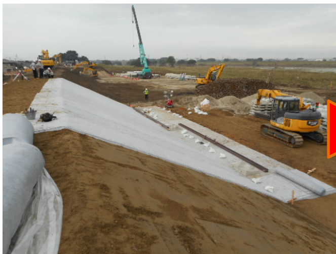
遮水シート設置着手 (9月16日6:00頃撮影)
