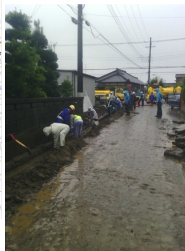
人力による 堆積土の 撤去
