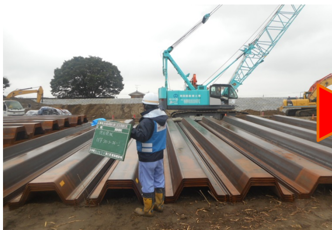
(備蓄) 鋼矢板搬入状況 (9月18日11:00頃撮影)
