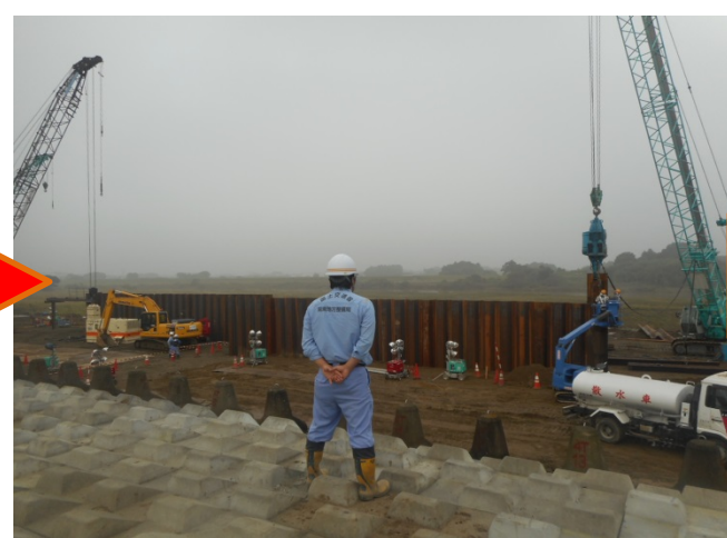
鋼矢板打設状況 (9月19日13:00頃撮影)
