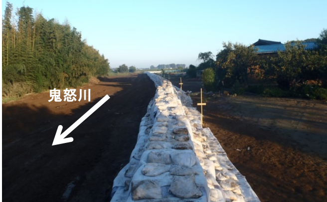
9月23日 大型土のう設置終了 (L=340m)
