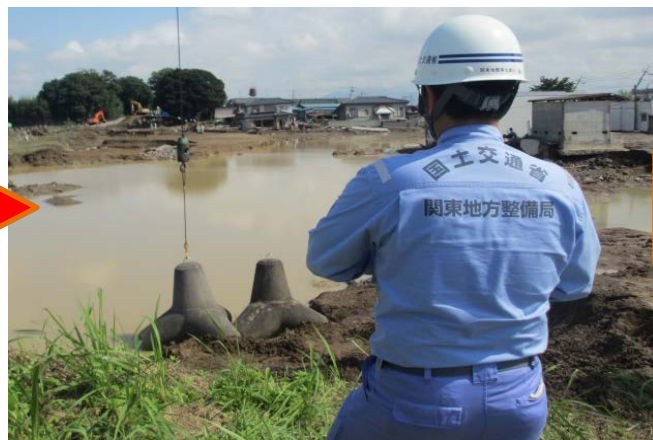
根固めブロック設置(下流) (9月12日9:00頃撮影)
