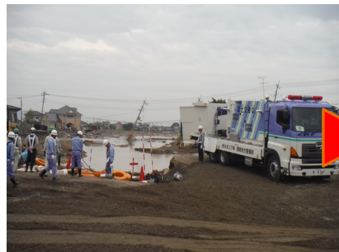
排水ポンプ車による落堀内排水 (9月13日16:00頃撮影)
