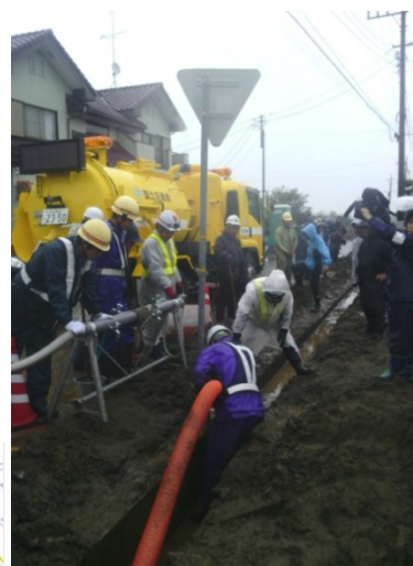
側溝清掃車 (バキューム付)による堆積土の撤去
