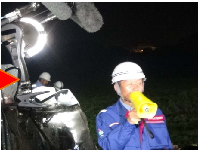
工事完了の現地説明（9月24日20:45頃撮影）
