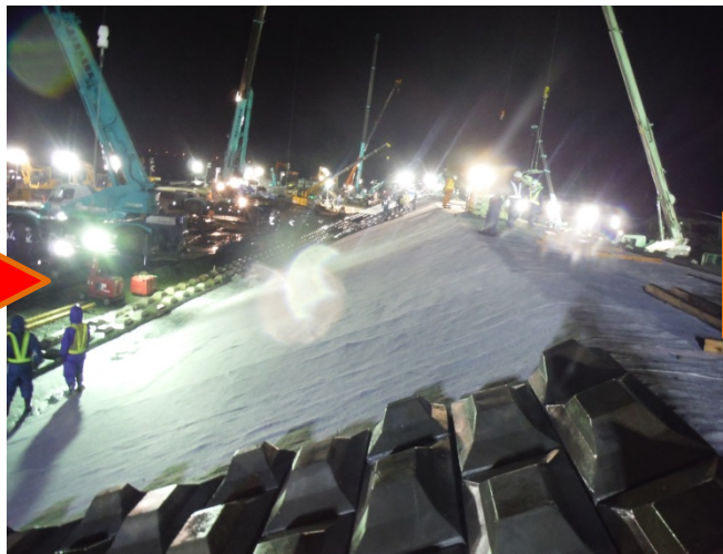
遮水シート・連節ブロック設置 (9月17日22:00頃撮影)
