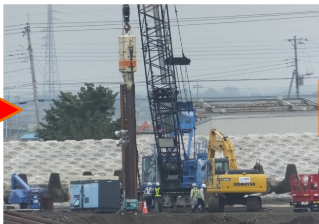
鋼矢板打設着手 (9月18日15:00頃撮影)
