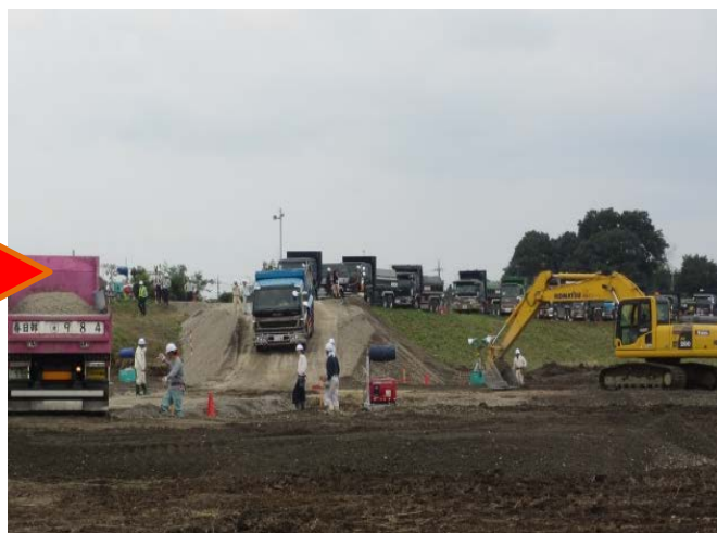
(備蓄)割栗石等運搬状況 (9月13日9:00頃撮影)
