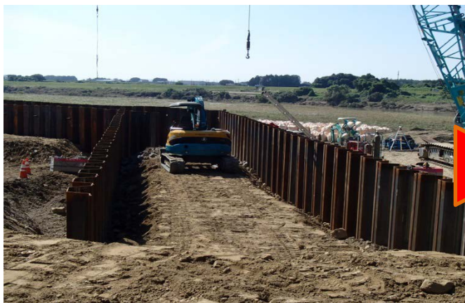
中詰土施工状況（9月22日15:00頃撮影）
