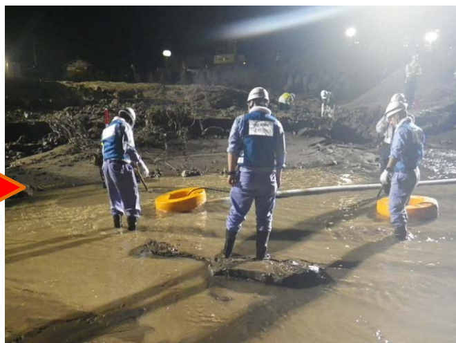
落堀排水確認職員立会状況 (9月14日0:00頃撮影)
