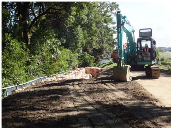
上流作業ヤード（9月11日15:00頃撮影）
