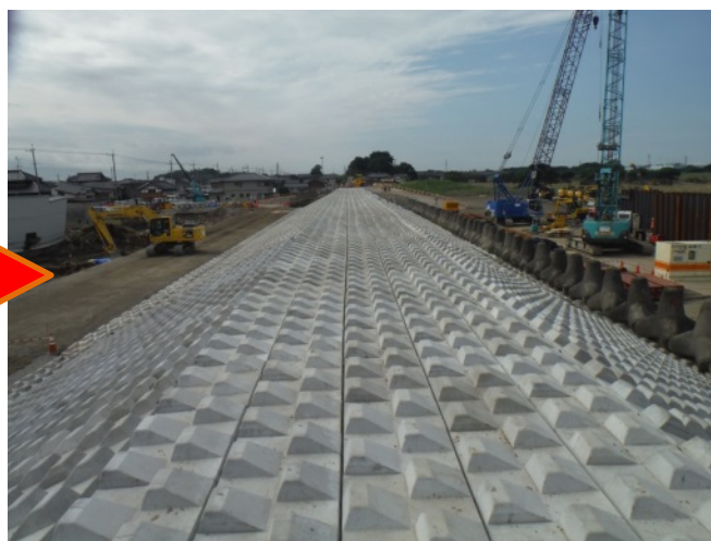
荒締切完了 (9月20日10:00頃撮影)
