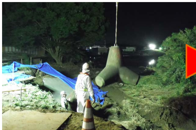
根固めブロック設置(上流) (9月11日22:00頃撮影)
