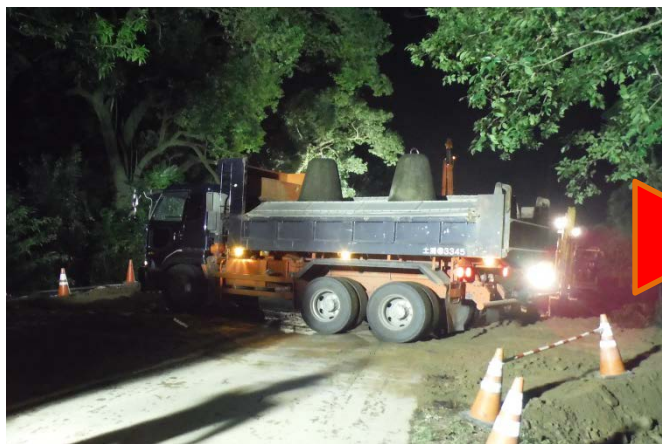
(備蓄)根固めブロック運搬(上流) (9月11日22:00頃撮影)
