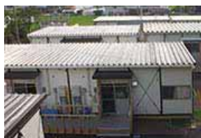
応急仮設住宅の建設
