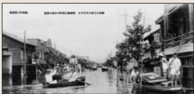
▲昭和13年6・7月洪水における土浦市内の浸水状況
