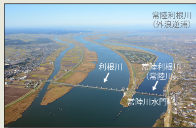
▲常陸川水門が設置された利根川合流部
