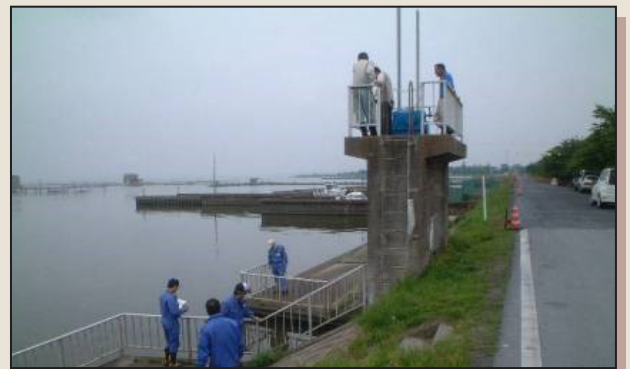
▲許可工作物の点検状況
