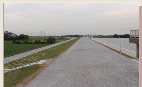
▲築堤整備の施工例
