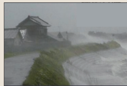
▲平成21年10月洪水における高波浪による越波状況
