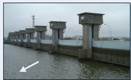
▲霞ヶ浦の水位を管理する常陸川水門
