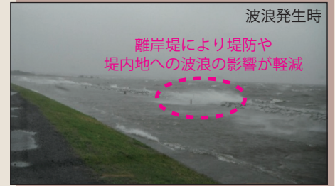
▲離岸堤による消波状況
