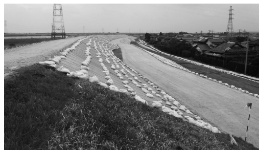
平成23年3月14日より約1ヶ月で応急対策を実施し 6月からの出水期に備えました
