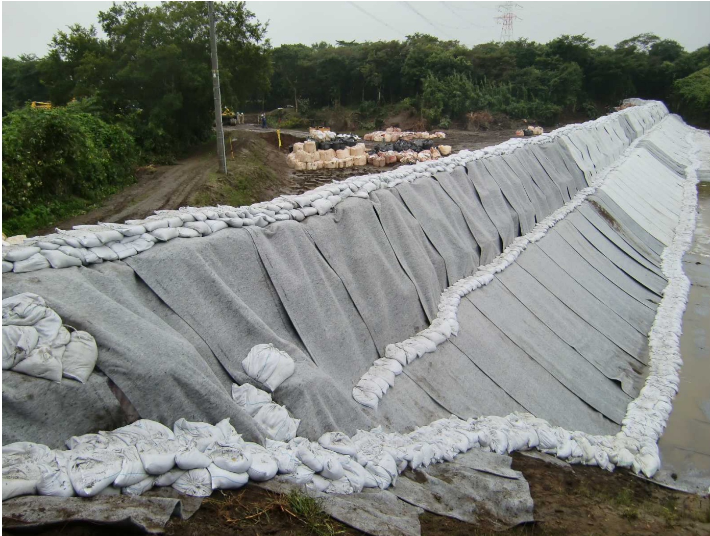
大型土のう設置完了(民地側より下流から上流をのぞむ)
