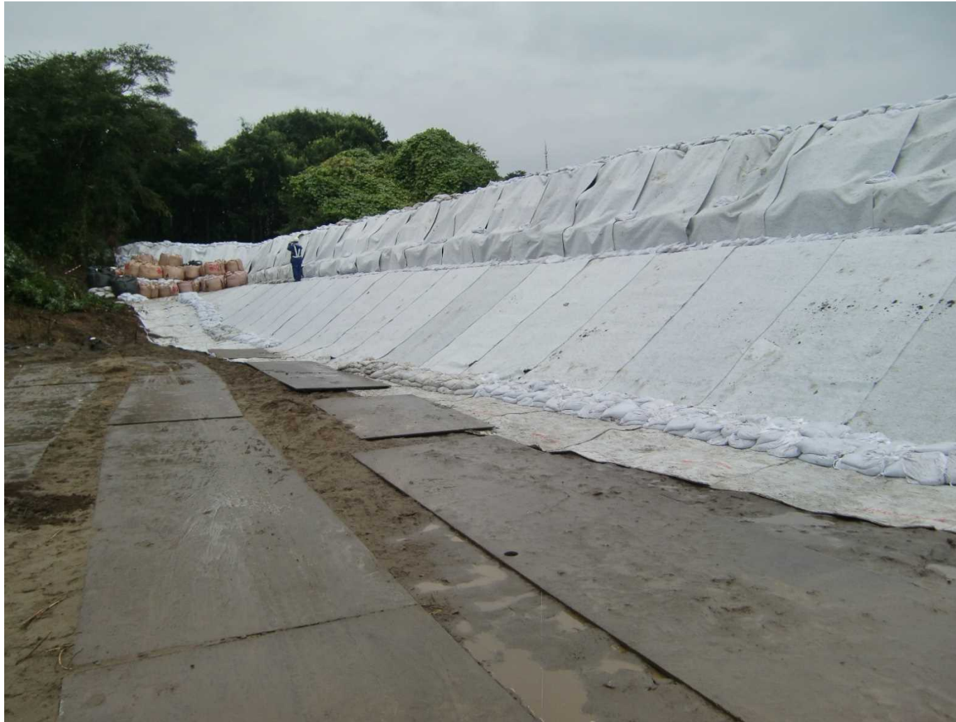
大型土のう設置完了(川側より下流から上流をのぞむ)
