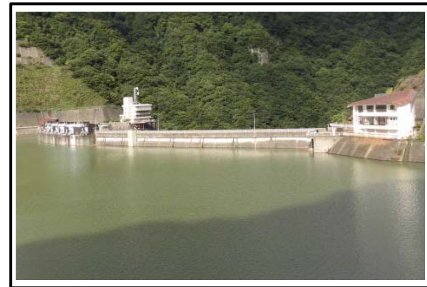
■ダム貯留後(平成27年9月11日 15時撮影 貯水位614.06m)
