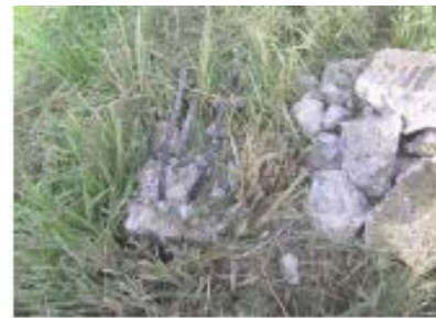
被害状況②
