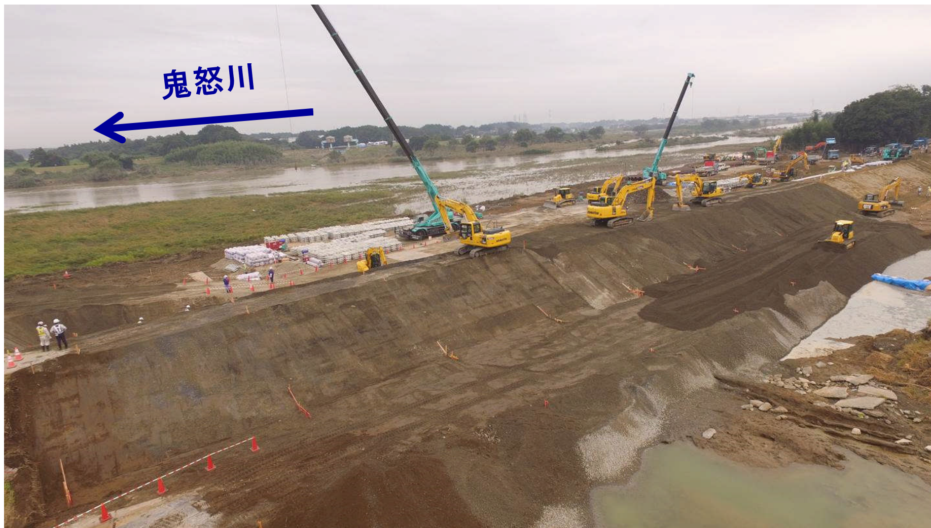
荒締切の盛土部完了(民地側の下流から川側をのぞむ)
