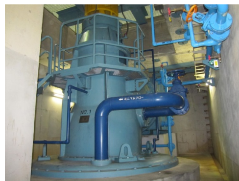
排水機場のポンプ
