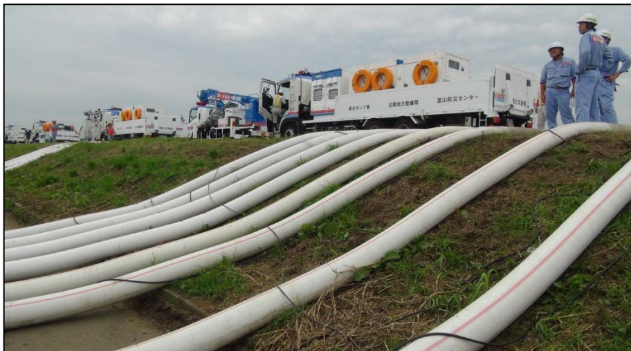
(茨城県常総市(大和橋付近))
