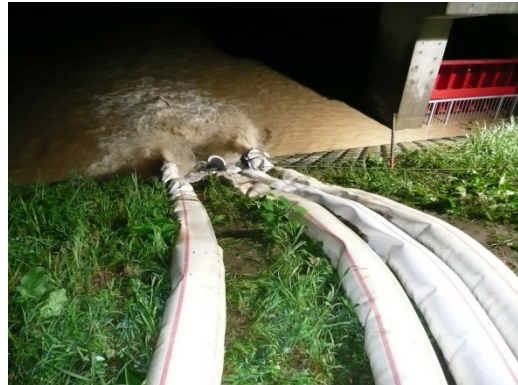
▲排水作業状況(河川側)
