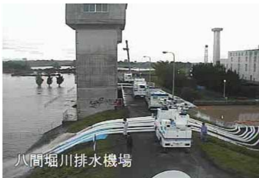
▲排水作業状況(全景)
