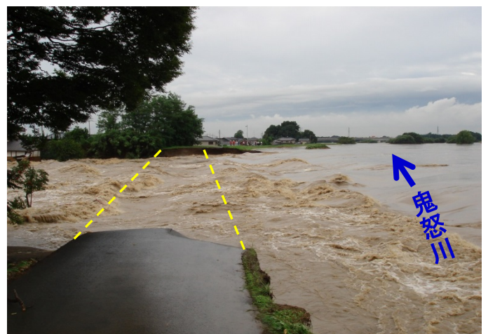
被災状況(拡大写真)
