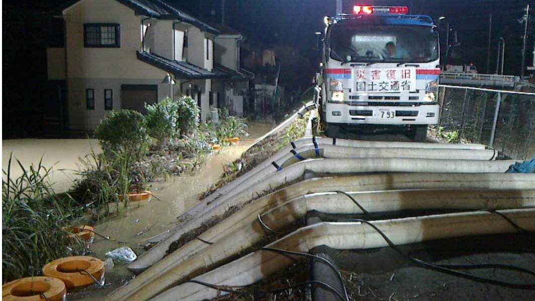
▲排水作業状況(住宅地側)
