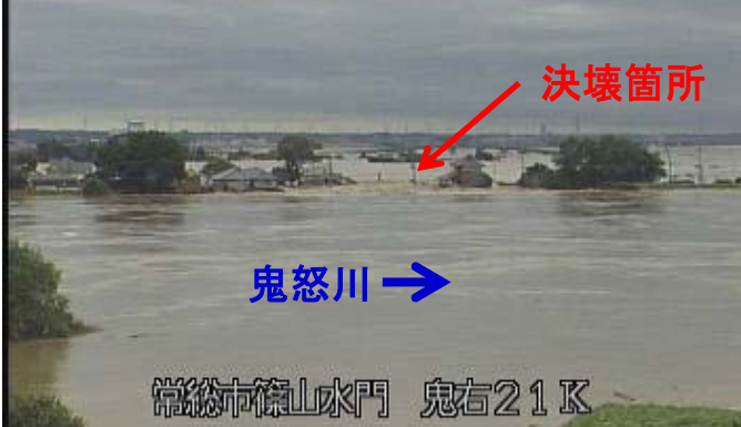
被災状況(対岸より撮影)
