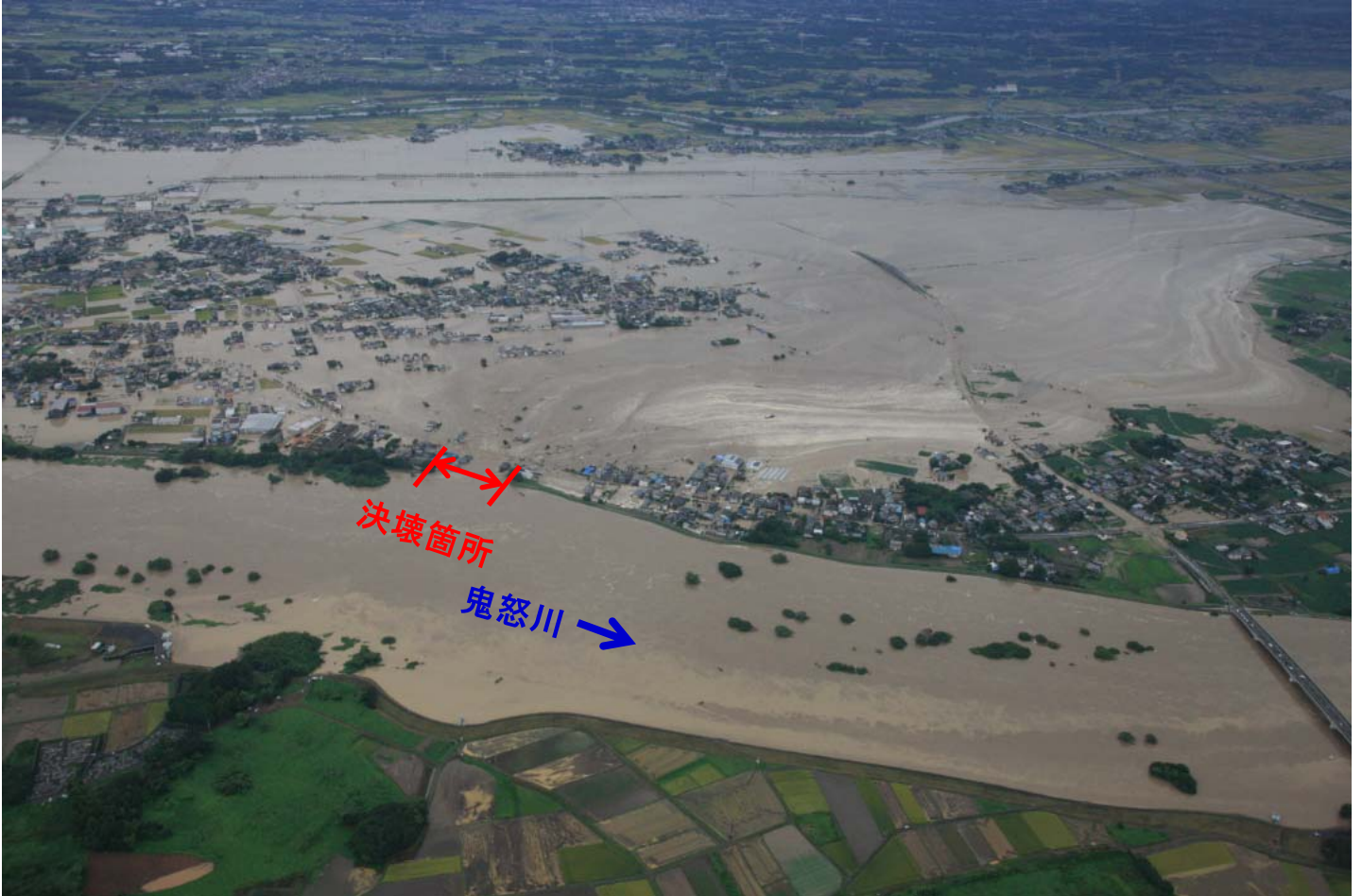
被災状況(全景写真)
