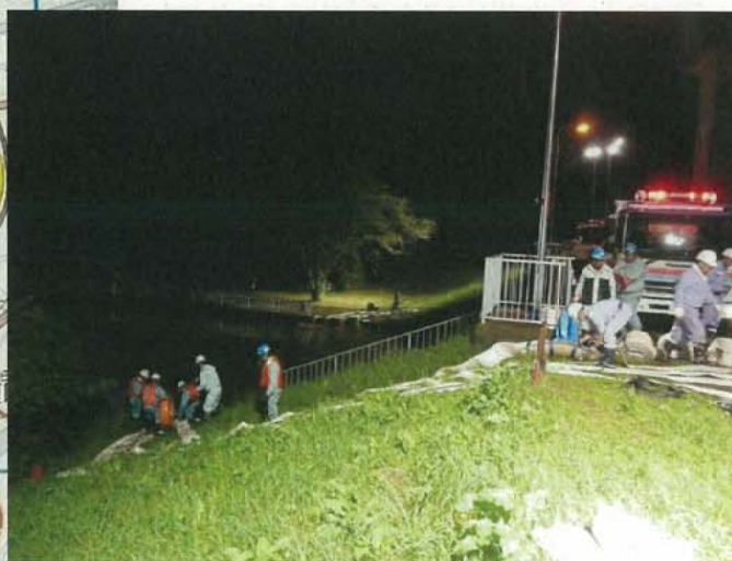
ポンプ車展開状況
