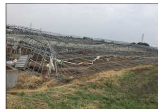
④倒壊したビニールハウス
