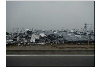
③倒壊した太陽光発電施設
