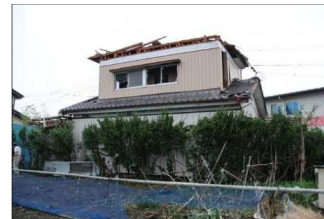
①屋根が飛んだ住家
