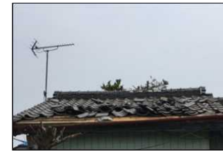
②屋根瓦がめくれた住家
