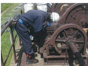
ゲート開閉装置の軸受の聴音点検 (動作中の異音の有無を確認)
