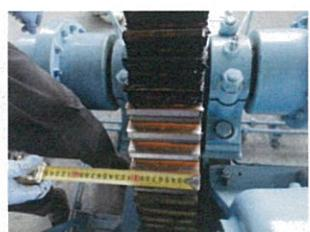
ゲート開閉装置の歯車の歯当たり点検 (歯車同士の接触状況の良否を確認)
