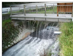
石灰石粉を投入し酸性河川を中和(湯川)
