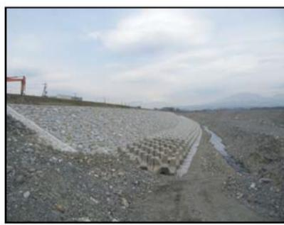
護岸の構築により、侵食を防止し、背後地の安全を確保する。
