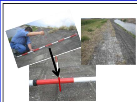
護岸の歪み及び経年劣化により護岸表面にも多数ひび割れが存在する。
