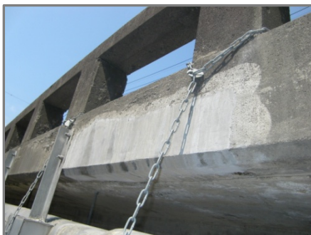
橋梁補修（断面修復）（イメージ）
