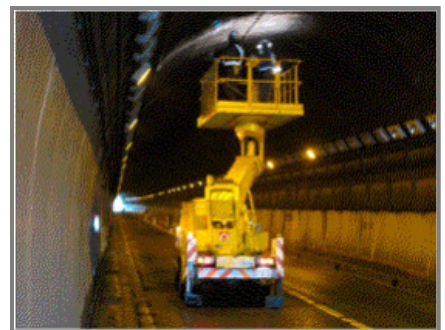
トンネル点検実施状況
