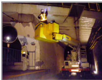
橋梁点検実施状況
