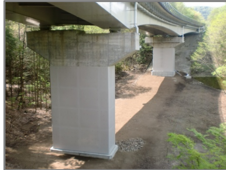
耐震補強(鋼板巻立て)(イメージ)
