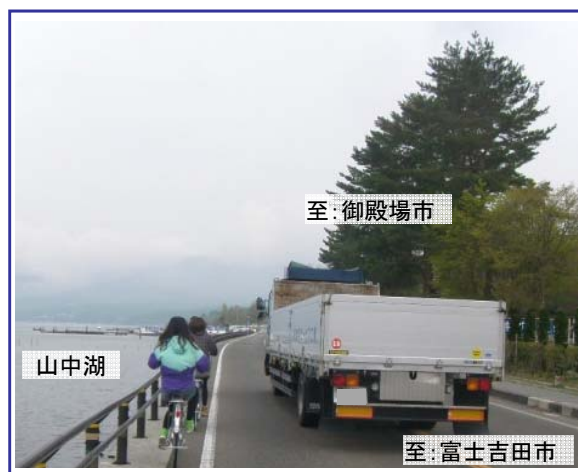
山中湖畔の国道138号の現況 [平成24年5月撮影]
