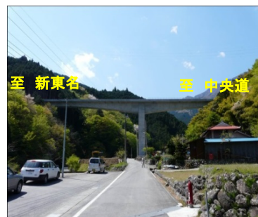
南部町楮根地区 (田中川橋(仮称)) 平成25年5月撮影
