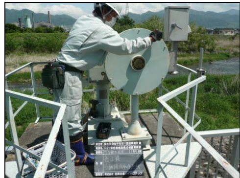
河川管理施設の点検
