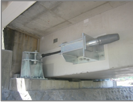
耐震補強(落橋防止装置)(イメージ)
