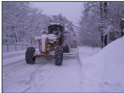
除雪作業状況
