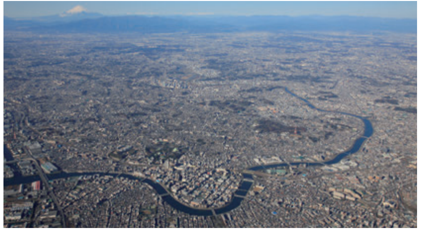
●川崎市長空から港北区方面を見ると、鶴見川下流部の蛇行の大きさがわかる
