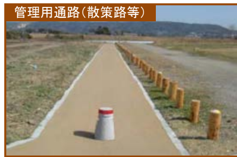
管理用通路(散策路等) 散策路により河川敷が利用しやすくなります
