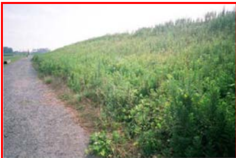
堤防の斜面が利用しにくい
