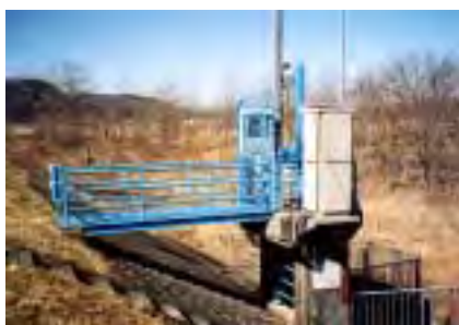
樋門・樋管（水門）
