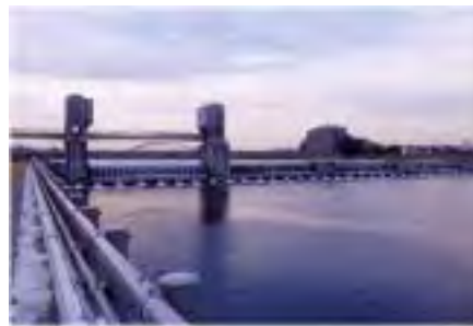
二ヶ領用水宿河原堰（狛江市－川崎市） 河口から 22.4km
