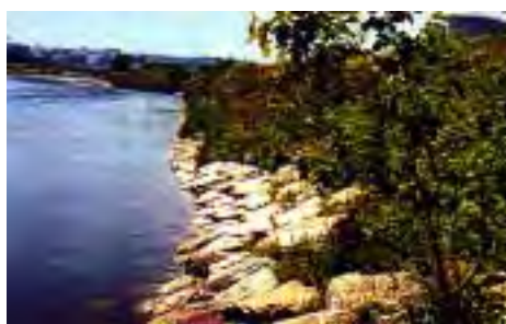
府中護岸（府中市） （多摩川の多自然型川づくり、京浜河川事務所）
