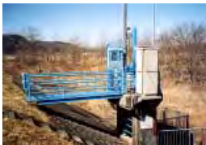
樋門・樋管（水門）
