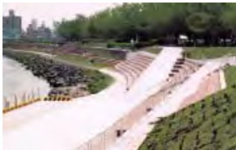
堤防（川崎市幸区） （多摩川スーパー堤防事業、京浜河川事務所）
