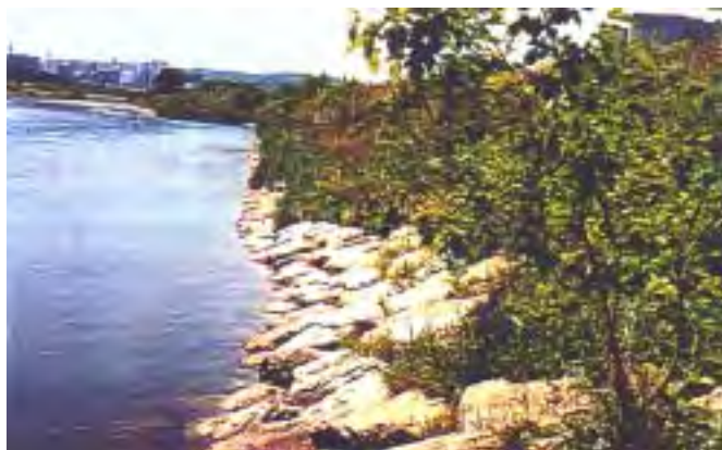
府中護岸（府中市）
