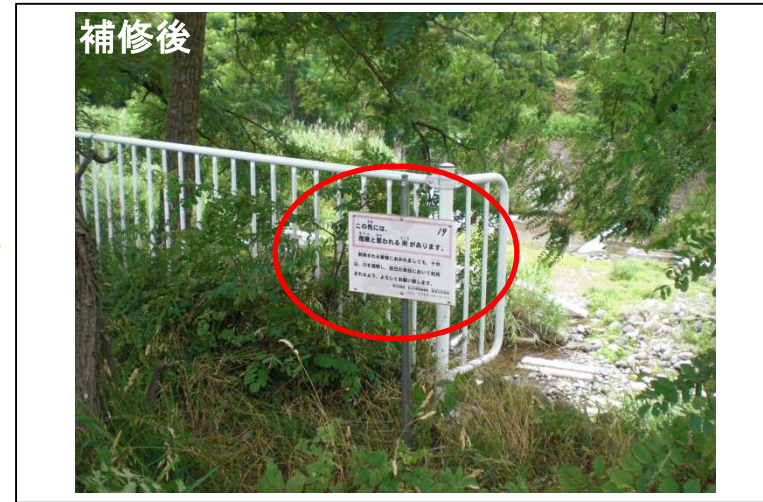
注意喚起看板付近の除草
