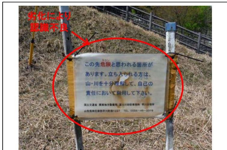
注意喚起看板が劣化により認識不良
