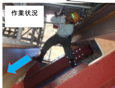
円筒型枠用固定ボルト 締込作業を実施していた
