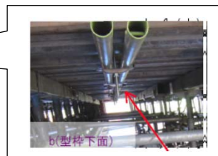
円筒型枠用固定ボルト 締込作業を実施していた
